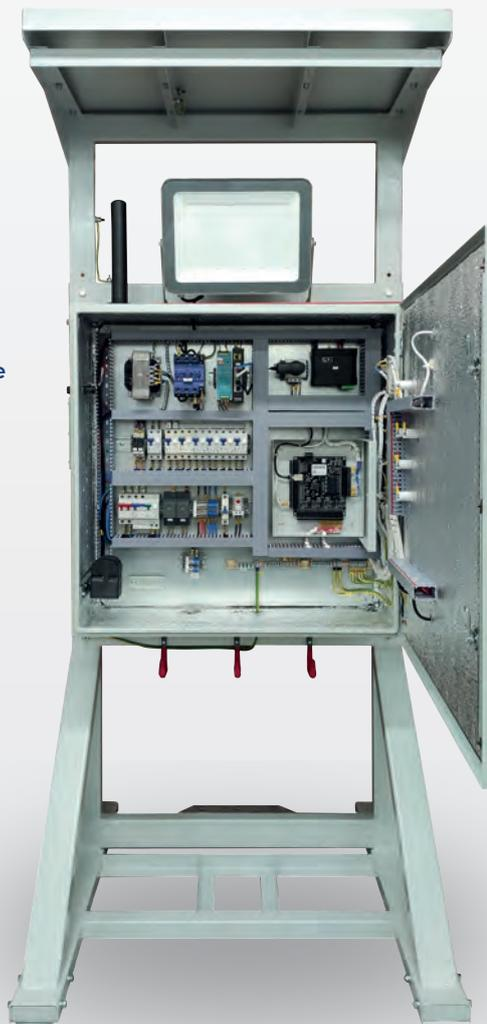
Предназначен для подключения электроинструмента при проведении локальных ремонтных работ на производственных площадках заказчика с применением ручного электроинструмента.
