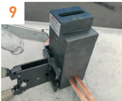
9) Подождите зажигательную смесь. Подождите примерно 30 секунд для завершения реакции и затвердевания расплавленного материала.
